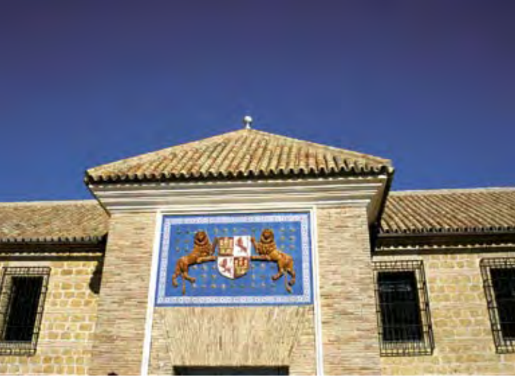
Portalschmuck am Parador Carmona
