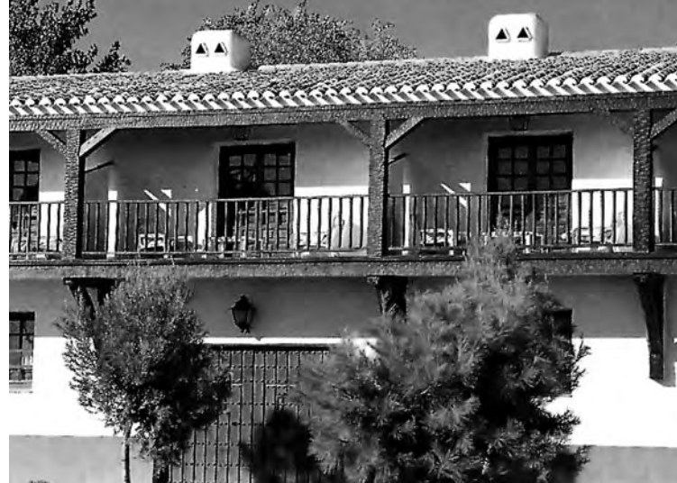
Zwei Stockwerke im Haciendastil: Parador Albacete
